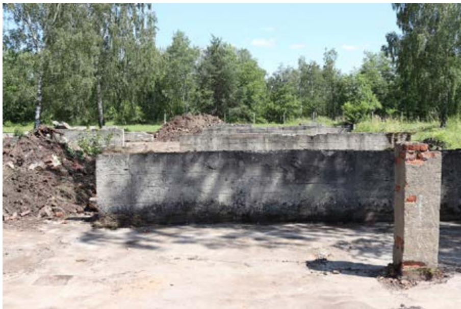
Pozostałości baraku VIII, segment 1 z widocznym fragmentarycznie zachowanym słupem podporowym (fot. E. Góra) Źródło: CMJW
