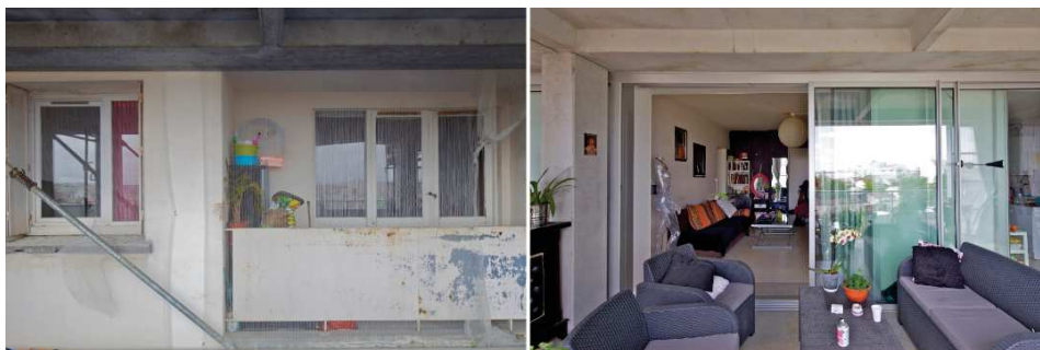
Zdjęcie 4. Ściana zewnętrzna przed i po realizacji inwestycji.
