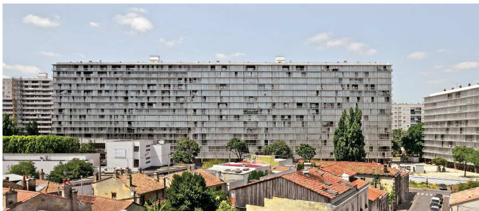
Zdjęcie 1. Modernizacja zabudowy wielorodzinnej w Bordeaux.
