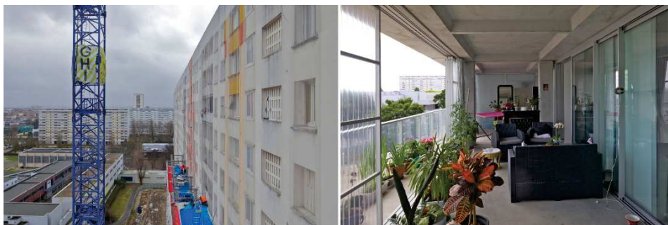
Zdjęcie 3. Budynek przez i po realizacji dodatkowego traktu.
