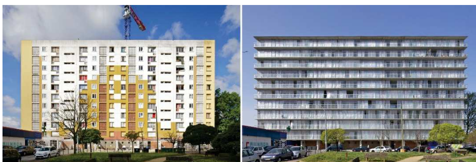
Zdjęcie 2. Zabudowa wielorodzinna przed i po modernizacji.
