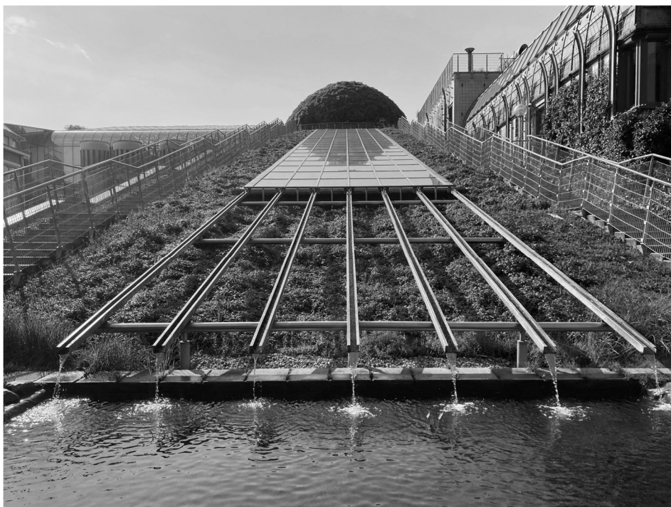
Rys. 6. Dach Biblioteki Uniwersytetu Warszawskiego – przechwytywanie wody opadowej, retencja oraz zastosowanie rekreacyjne
