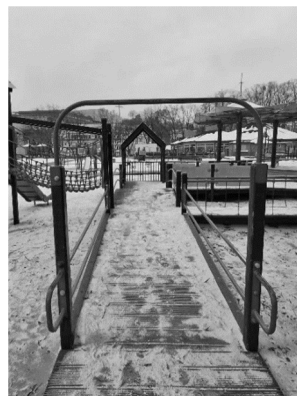
Fot. 21. Rampa wjazdowa na jedno z urządzeń (lokalizacja G2)
