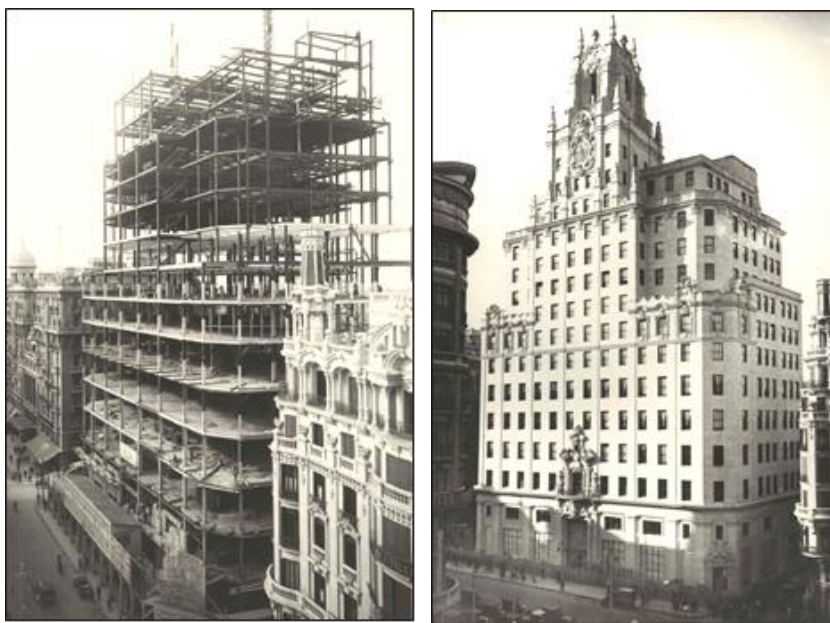
Fig. 1. Palatul Telefónica din Madrid. Fază intermediară de execuție (31.03.1927) (stânga).
