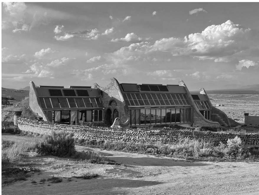
Fot. 4. Budynek mieszkalny typu earthship wykonany z materiałów odpadów i recyklingu
