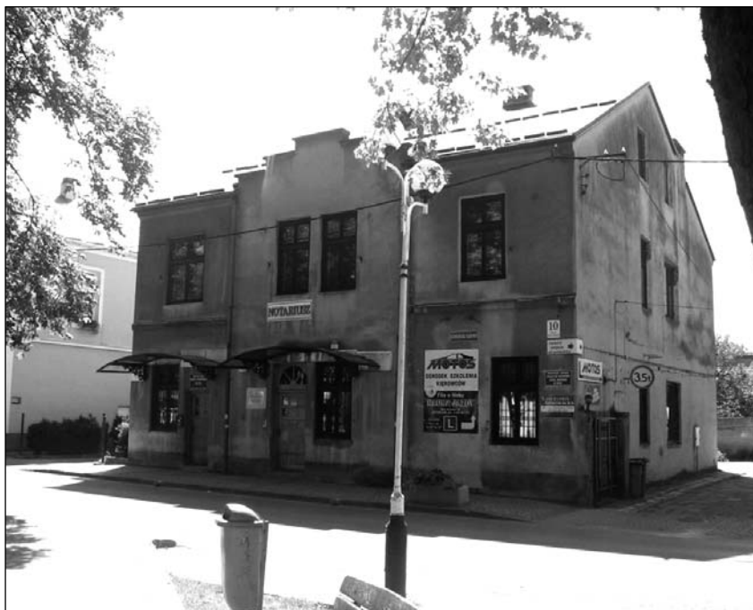
Fot. 1. Budynek dawnej siedziby Komendy Powiatowej Milicji Obywatelskiej przy Placu Wolności 10 w Nisku (widok współczesny – stan na dzień 21.08.2010 r.).
